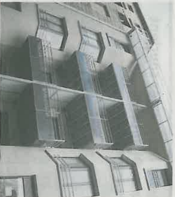
Le quartier Chavanelle proposera dans quelques mois un bel ensemble de dix appartements dont huit logements dans un immeuble de quatre étages avec ascenseur rue Henri-Barbusse. Photo Isabelle Rochas
